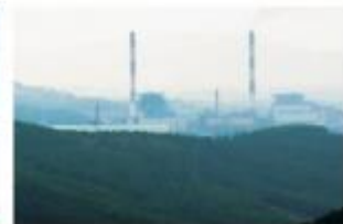
▲ Hình 10.8. Nhà máy nhiệt điện
